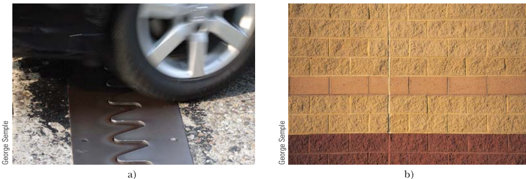
Figura 19.7 a) Las juntas de expansión térmica se usan para separar secciones de autopistas en los puentes. Sin estas juntas, las superficies se pandearían debido a expansión térmica en días muy calientes o se fracturarían debido a contracción en días muy fríos. b) La junta vertical larga se llena con un material suave para permitir que la pared se expanda y contraiga a medida que cambia la temperatura de los ladrillos.
